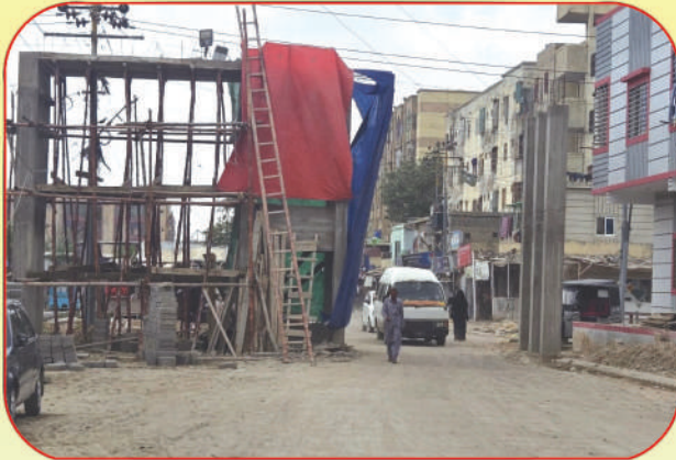
مرکزی داخلے پر آرچ ڈیزائن (زیر تعمیر)
